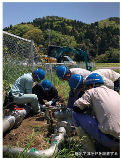
仮設管敷設後は地域住民に周知した。水道局業務課の梅津主任は「皆さん親方クラス、何も言わなくても工程が進むのほろほろです。レックス管(仮設管)敷設の経験があることも大きい」と目を細める。今回の仮設管敷設によって、ようやく通水漏水の解消ができる。しかし、「私たちができるのは家のメーターまで。その先は個人の財産なので、各自でやらなければなりません。業者さんが足まかせと熊倉給水係長は心配していた。
