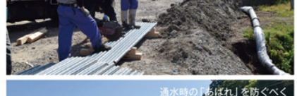
通水時の「あはれ」を防ぐべく、単管を打ち込み、番線で固定。
