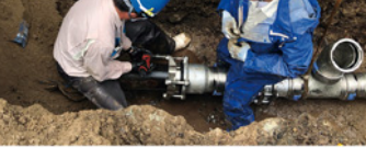
旧配水管と仮設管をつなぐ。
