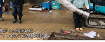
曲がった箇所には「フレキシブル管」を設置。
